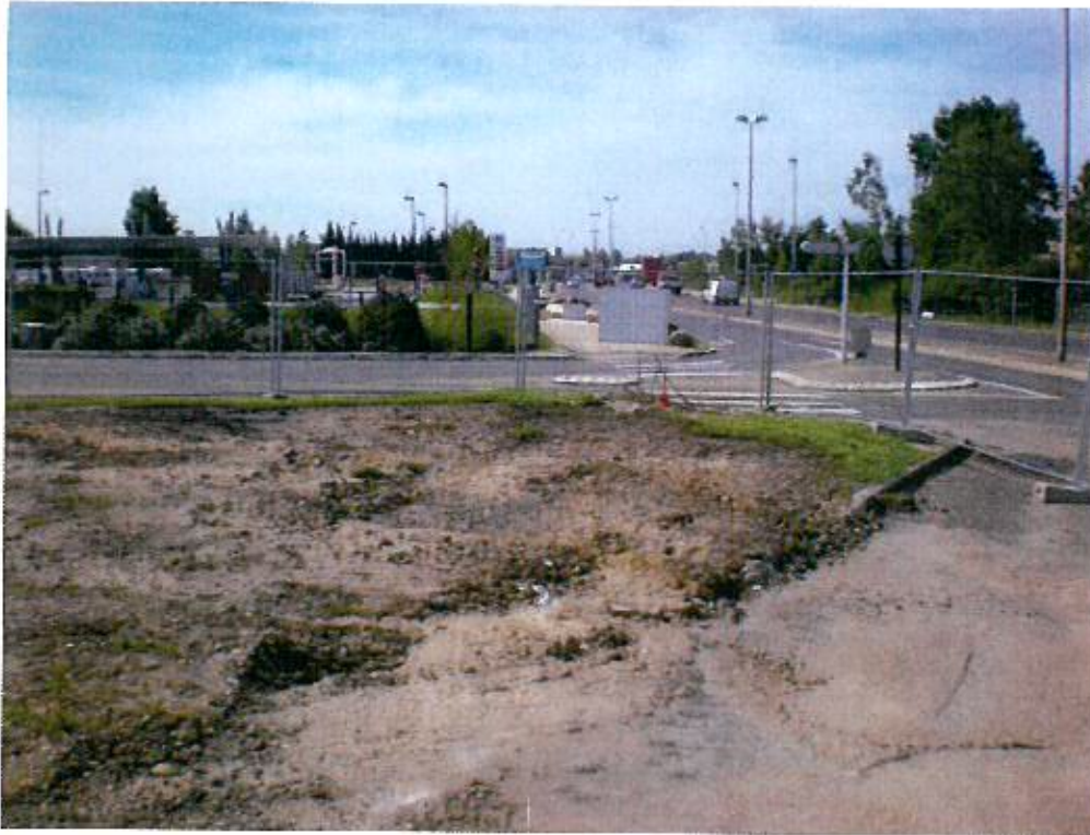
Fouille ancien séparateur remblayée – 10 - 05-2012
