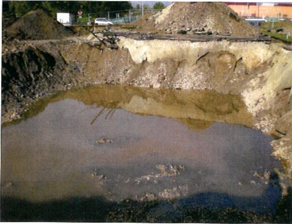
Fouille anciennes cuves – 19-04-2012
