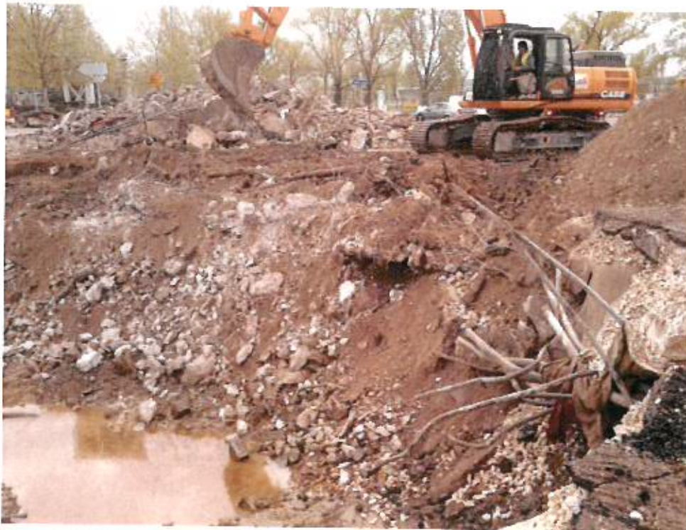
Fouille anciennes cuves – terrassement accès – 3-04-2012
