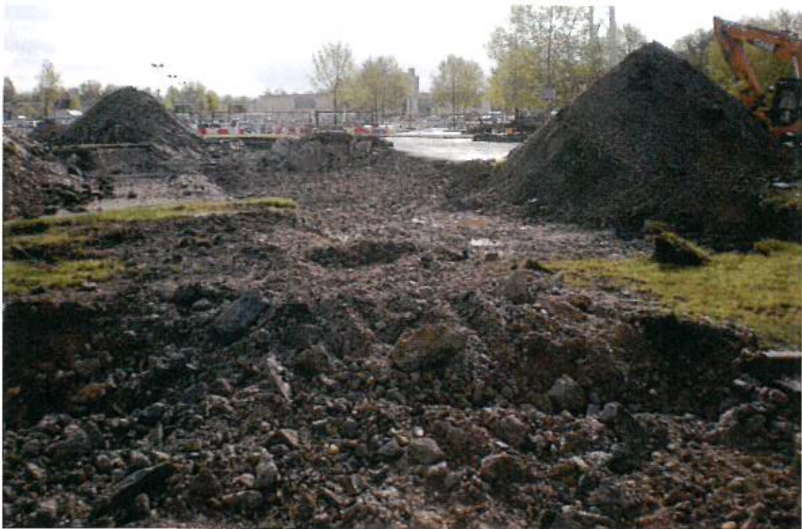
Fouille dépotage et postes de distribution – 11-04-2012
