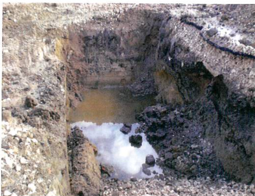
Fouille « S8 » à proximité postes de distribution – 19-04-2012
