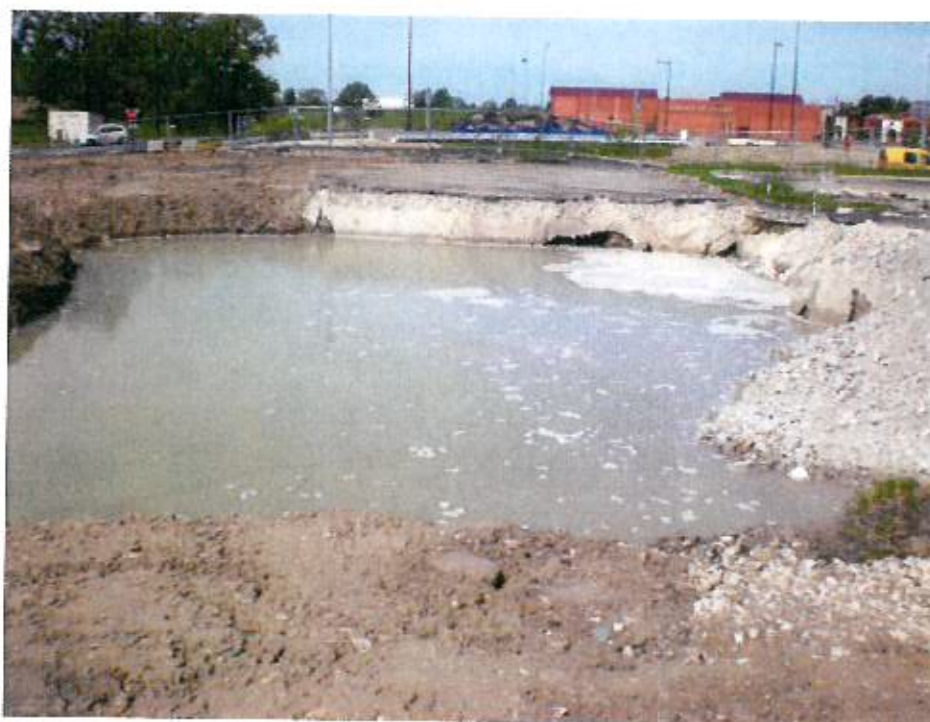
Fouille des cuves partiellement remblayée – 10-05-2012
