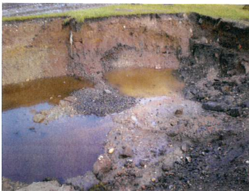
Fouille séparateur et « S12 » - 19-04-2012
