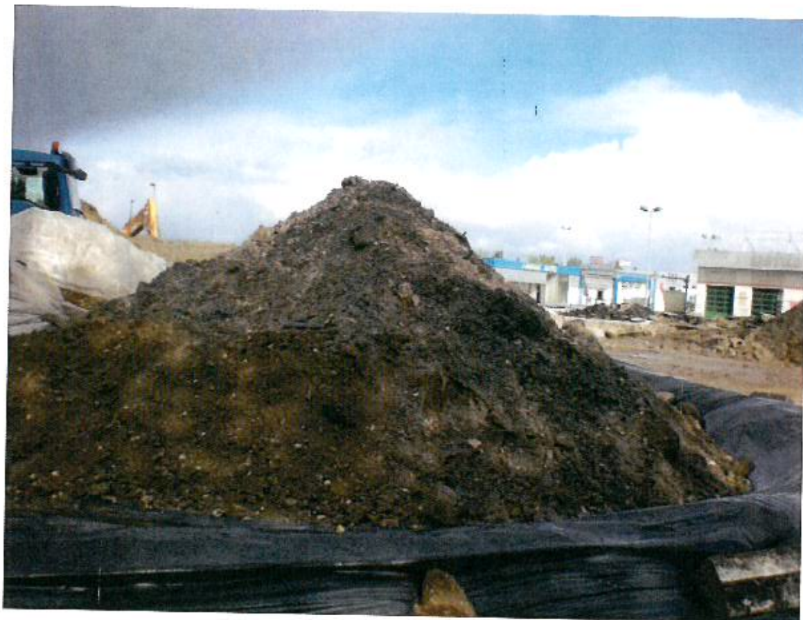
Aire de stockage des terres impactées (tas complémentaire TI2) – 19/04/2012
