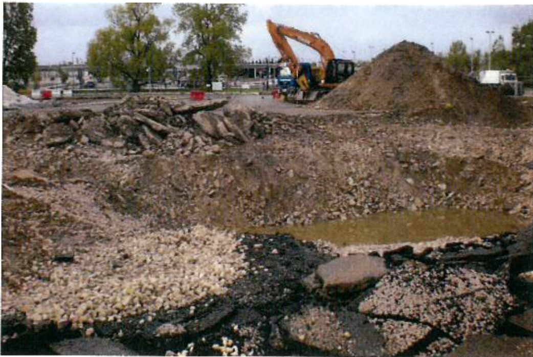
Fouille anciennes cuves – 11-04-2012
