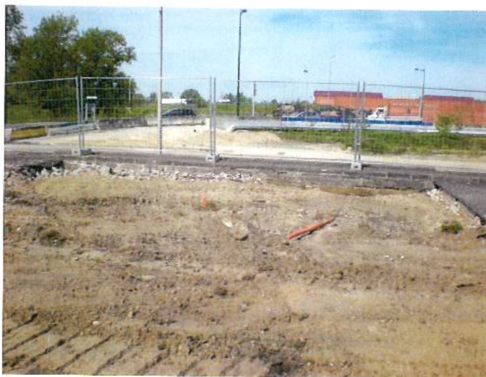
Fouille ancien dépotage remblayée – 10 - 05-2012
