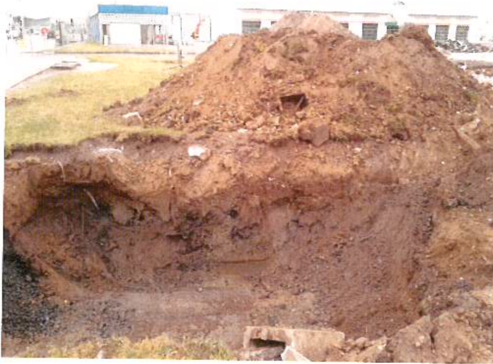
Fouille séparateur à hydrocarbures – 3-04-2012
